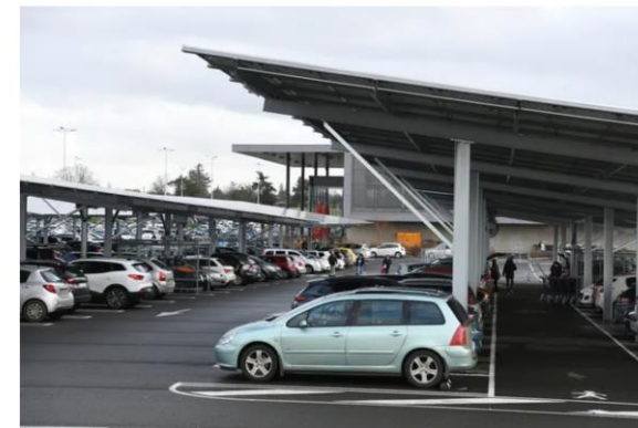
Des ombrières recouvrent désormais le parking du centre commercial Leclerc Les portes de Fallier à Avermes. © Philippe BIGARD
